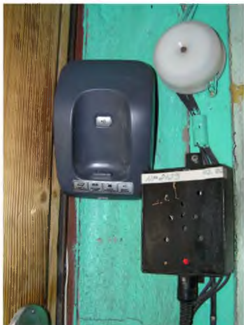
Рис. 3.32. Установка базы телефона вблизи входной двери
