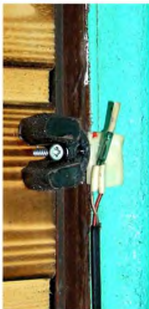
Рис. 3.33. Вид на контакты переключателя-геркона, срабатывающего при откры- вании входной двери
